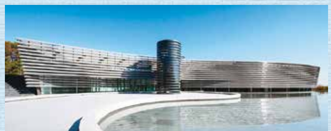
▲インスタントラーメンの「麺と切刃」をイメージした外観
