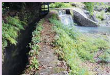
▲古淵の堰から流れ出る浅川疏水
